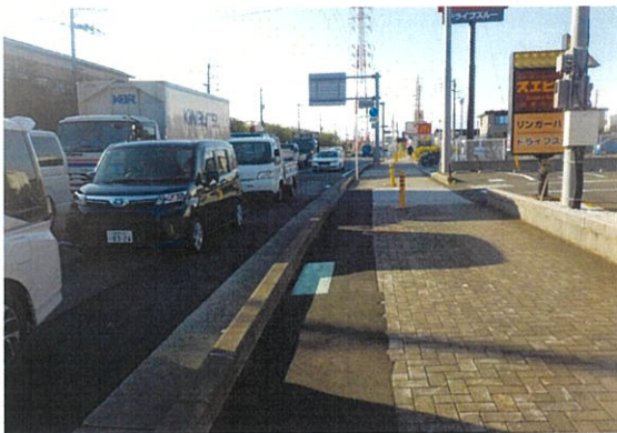
電線地中化整備状況
