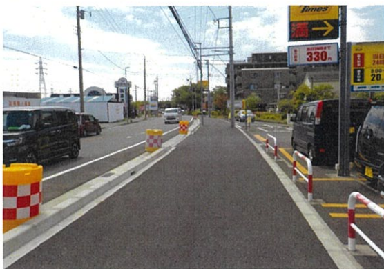
歩道整備状況
