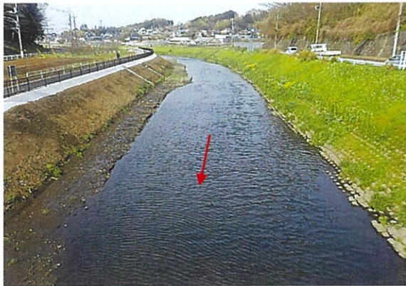
道庵橋上流(整備中)
