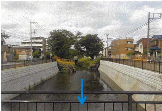
福田7号橋上流
