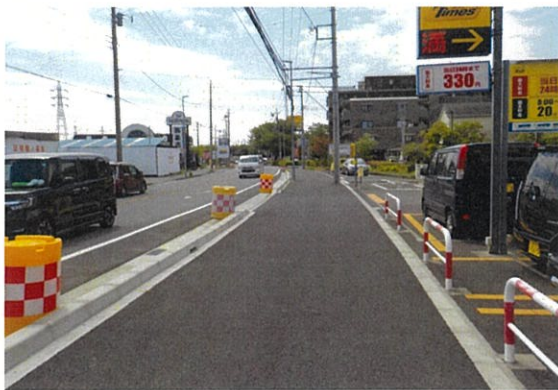
歩道整備状況
