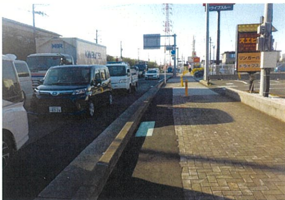
電線地中化整備状況
