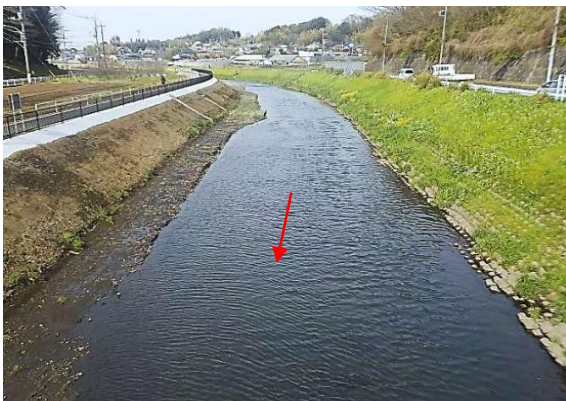
道庵橋上流(整備中)
