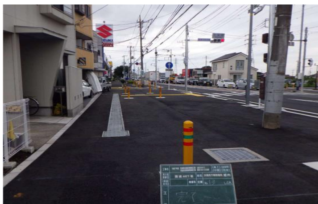
令和7年度歩道整備状況
