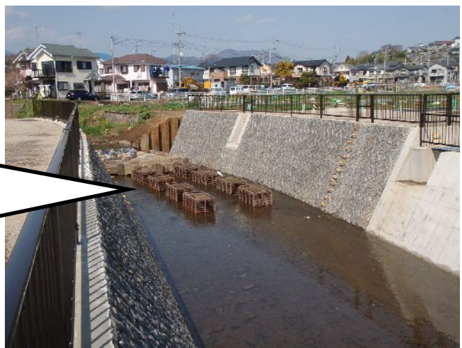
厚木市 恩曾川 水質浄化ブロック
