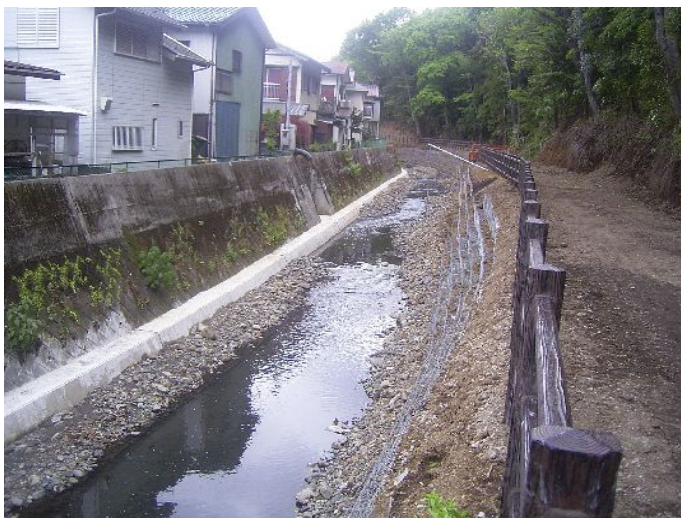
相模原市 姥川 改修工事
