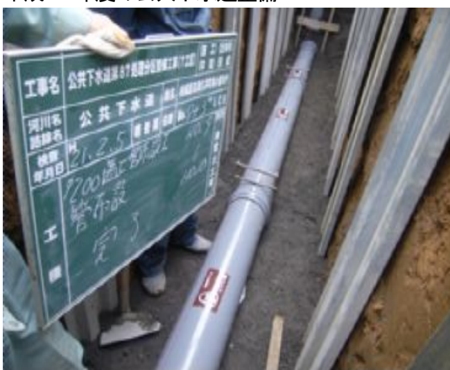
管路開削工事（相模原市津久井町）
