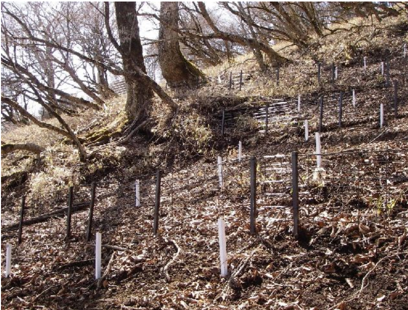
写真 金網筋工（茶色の網の中及び上部に落枝落葉を貯留させて土壌流出防止効果を発揮する施設）施工箇所内に設置した土砂移動量調査枠（白色鋼製柱が枠状に設置されている）
