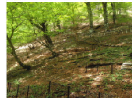
様々な土壌流出防止工で土壌流出を防ぐ
