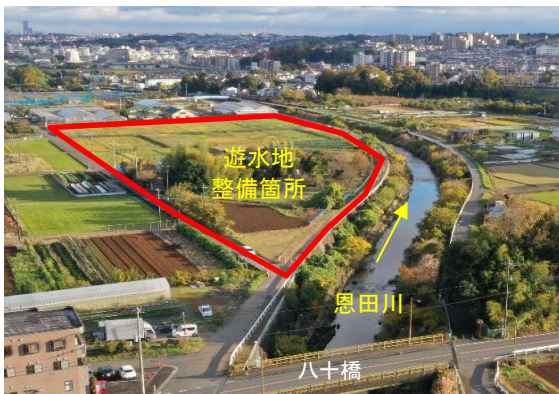
遊水地整備箇所写真 (八十橋より下流方向)
