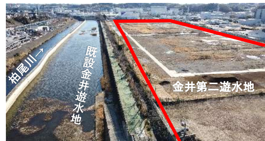
金井第二遊水地整備箇所（写真①）
