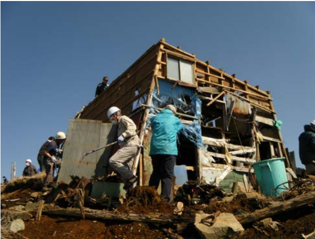
廃屋の撤去状況（秦野市 塔ノ岳山頂）
