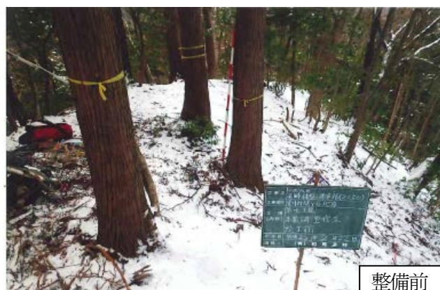
溪畔人工林 本数調整伐と植生保護柵設置（本谷川）
