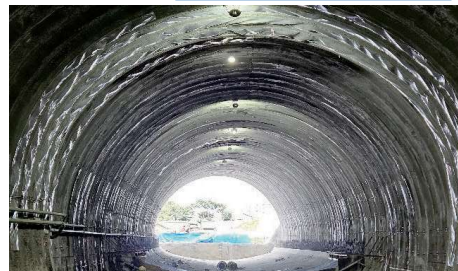
小田原市多古付近トンネル部整備状況
