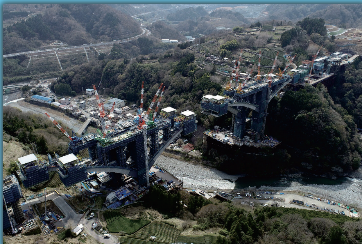
新東名高速道路 河内川橋
