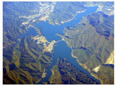
宮ヶ瀬ダム 山林からの流入のみの場合
