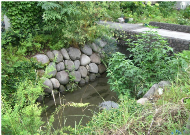
護岸は空積みである
