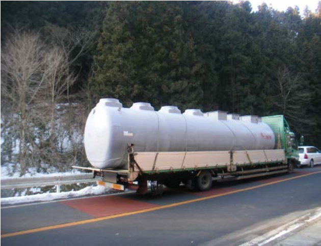
公衆トイレの高度処理型浄化槽(50人槽)の搬入。
