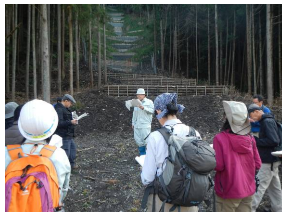
山北町山市場 (スコリア崩壊現場の治山工事後)
