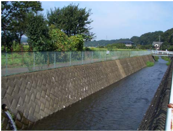
厚木市 善明川 <整備前>
