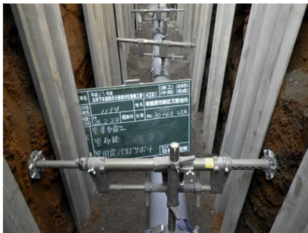
開削工法による下水道管の敷設
