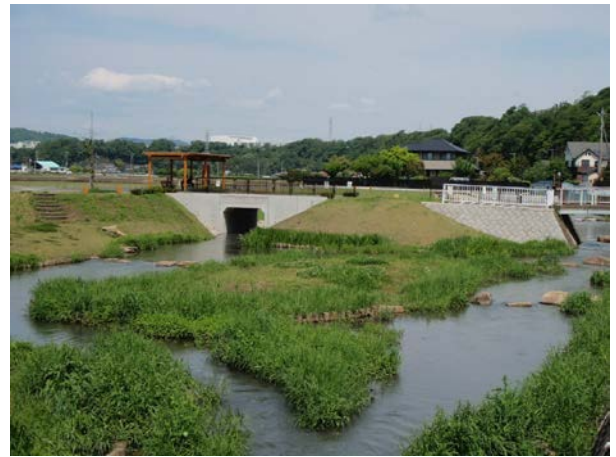
厚木市 善明川 <整備後>
