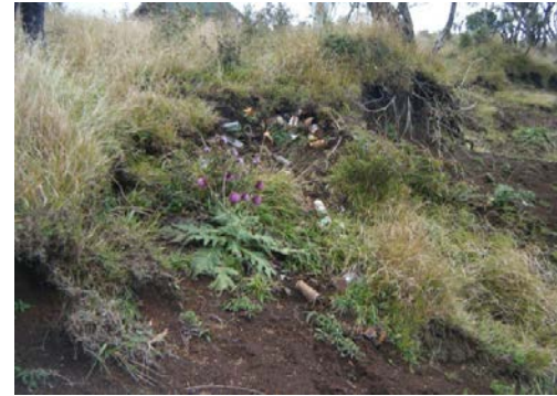
【埋設ゴミの露出】
