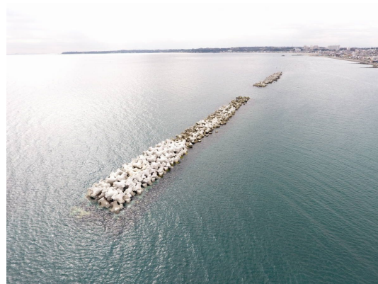
離岸堤（北下浦漁港海岸）
