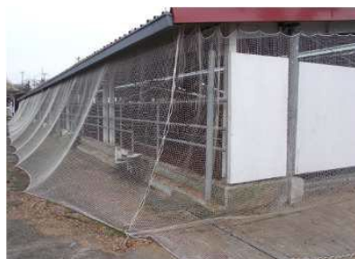
防鳥ネットの補修
