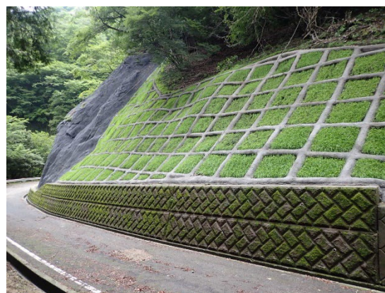
仲の沢林道 法面保護工（山北町）
