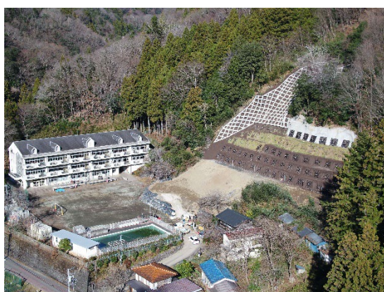
山腹工施工地（相模原市緑区）
