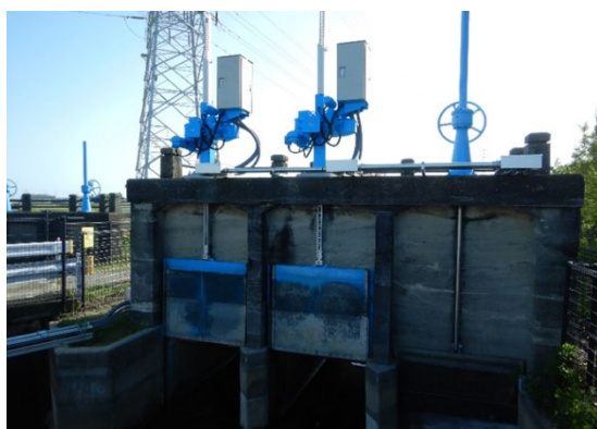
水門の遠隔電動操作化
