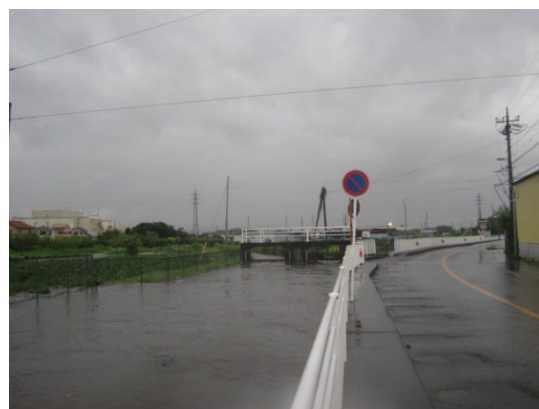
水路拡幅による周辺被害防止
