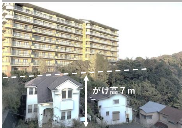
吉倉町地区（横須賀市）：R6工事实施
