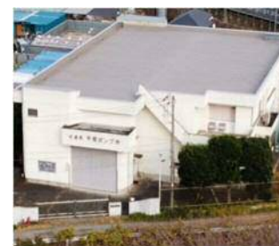
平塚揚水ポンプ所
