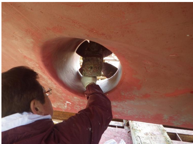
船長によるスラスター研磨作業
