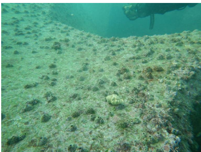
図4 ブロックに付着するフジツボ類
