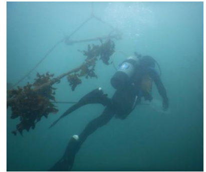
図7 潜水でカジメを設置
