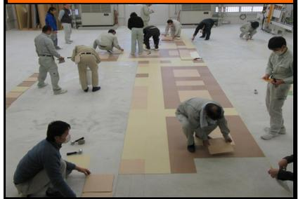
基本の施工法をマスターしたのち、実際の現場で接着剤を使い、応用的に床材を張る方法を習得します。
