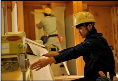
施工ブースにて、下地調整の仕方、無地・柄物クロスの施工法を学びます。突き付け、ダブルカットなどの基本テクニックを習得します。
