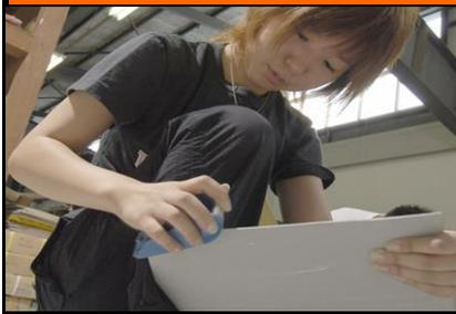
施工ブースにて、プラスチック床タイル、クッションフロア、長尺シートの施工法を習得します。
