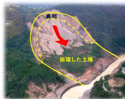
深層崩壊の例
