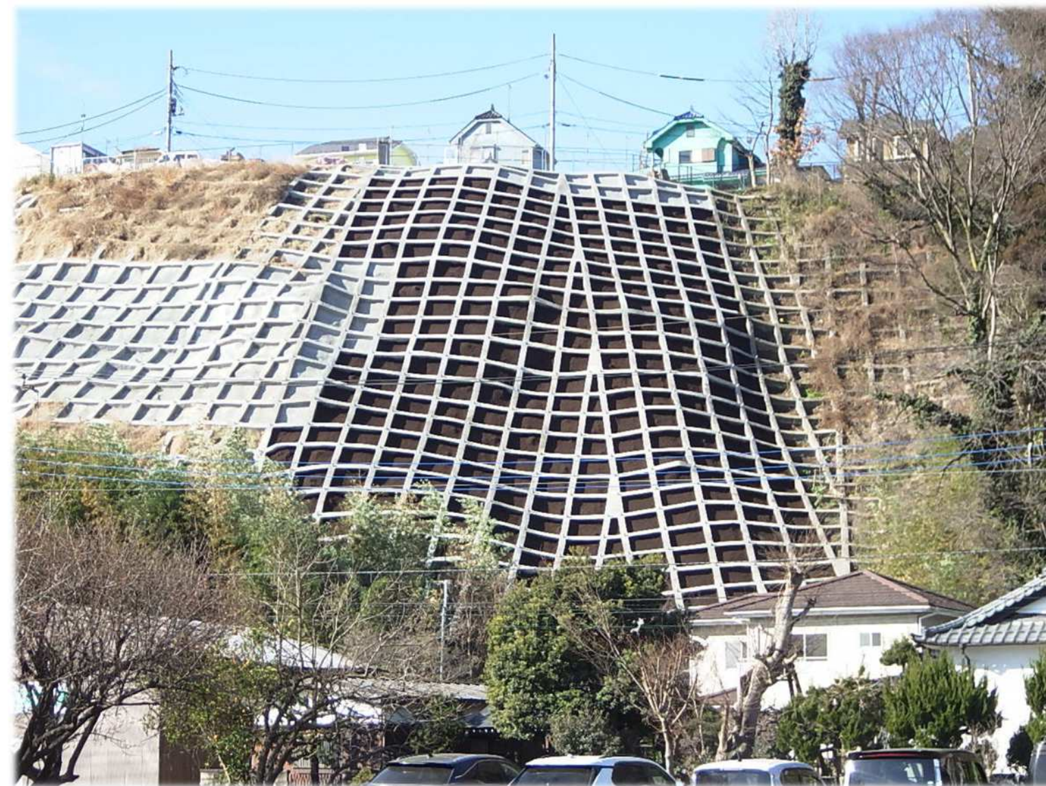
急傾斜地崩壊対策工事の状況（急傾斜地崩壊危険区域 山際地区）令和4年2月撮影
