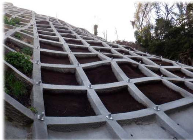
アンカー付法砕工（山際地区）
