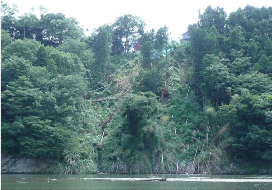
湖岸 斜面 崩落箇所の例
