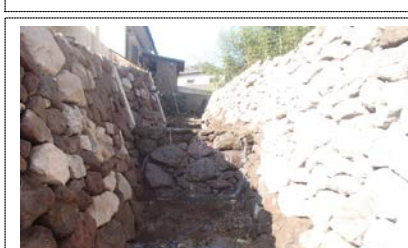
⑥河川・水路における自然浄化対策 自然石による護岸とし、礫間浄化を促進させた。(伊勢原市藤野用水路)
