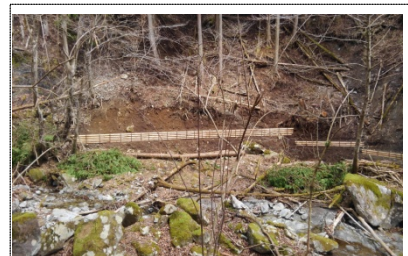
③溪畔林整備 土壌流出が発生している、あるいは発生しそうな箇所に土壌保全工を実施した。(山北町大滝沢)
