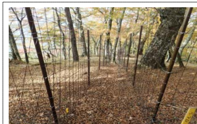
②丹沢大山の保全・再生 シカによる採食を防ぎ、植生を回復させ、土壌を保全するため、植生保護柵を設置した。(山北町中川)
