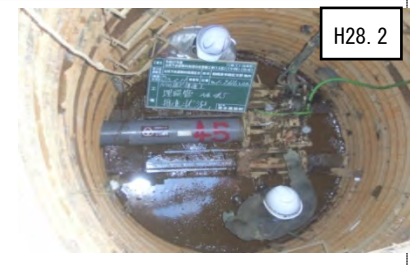
⑧⑨ダム集水域の生活排水対策（下水道・浄化槽） 推進工法（道路を開削せず、トンネル上に掘削した穴に管を通す工法）により管を敷設した。（相模原市緑区）
