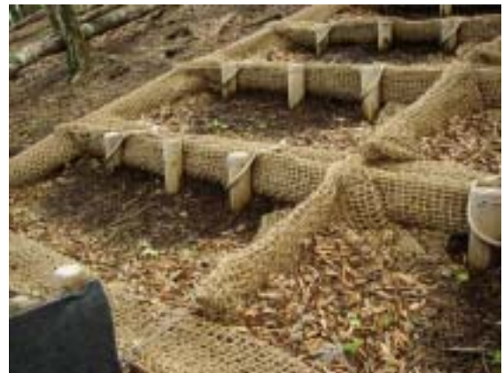
土壌流出対策工
