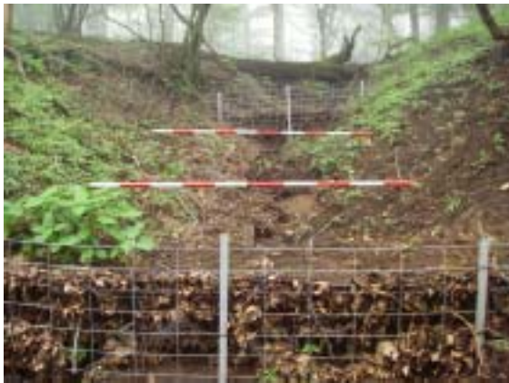
土壌流出対策工
