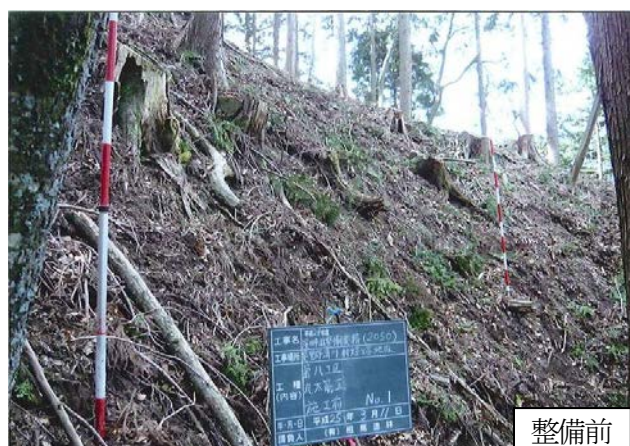
溪畔人工林 土壌保全工（境沢）
