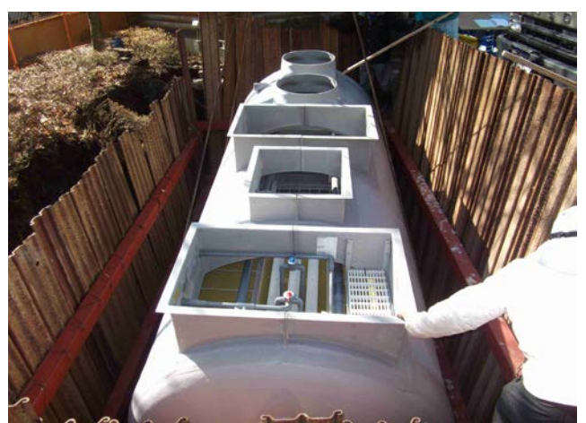
公衆トイレの高度処理型浄化槽(25人槽)をクレーンで所定の位置に据付ける。
