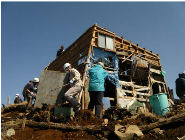
廃屋の撤去状況（秦野市 塔ノ岳山頂）
