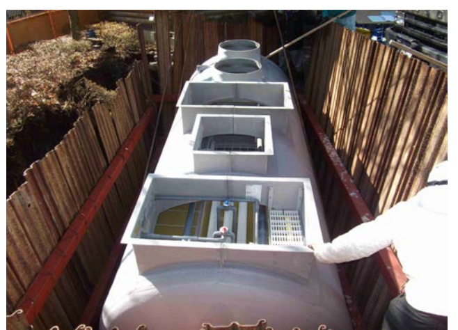
公衆トイレの高度処理型浄化槽(25人槽)をクレーンで所定の位置に据付ける。
