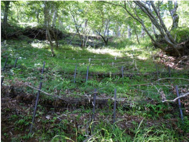
土壌流出防止対策（清川村 丹沢山東側山腹斜面）
