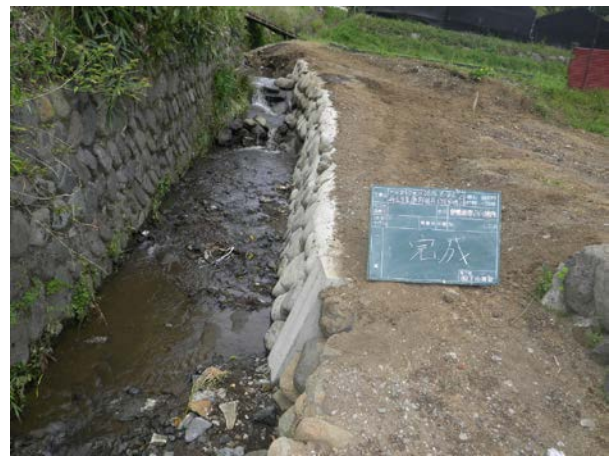
<整備後> 自然石を用いた護岸整備を行い、植物や生物の生息域を確保した。
