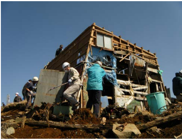
廃屋の撤去状況（秦野市 塔ノ岳山頂）
