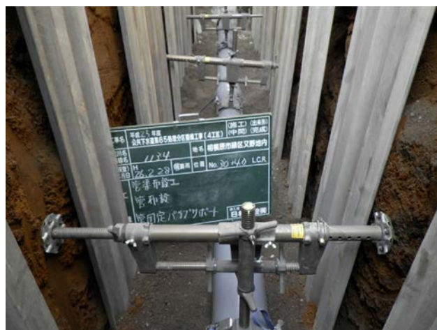
開削工法による下水道管の敷設
