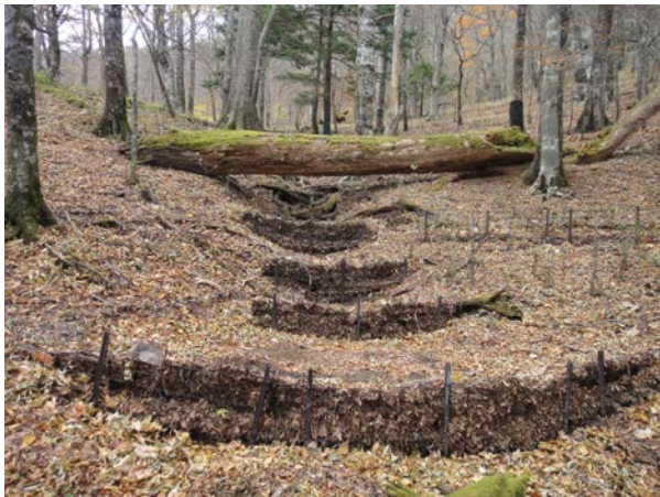
土壤保全対策工事 (清川村 丹沢山東側山腹)
