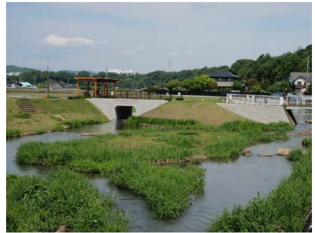
厚木市 善明川 <整備後>
