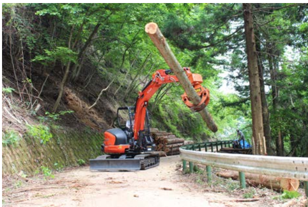
林業機械による労働負荷軽減と安全な搬出作業
