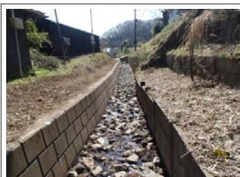
⑥河川・水路における自然浄化対策 川底に礫(れき)を敷くことで、自然浄化機能を高める取組。(伊勢原市藤野用排水路)
