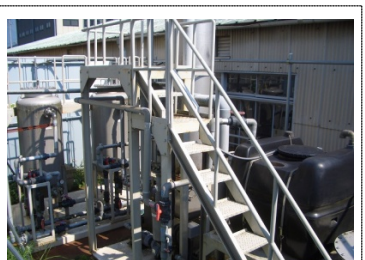
⑦地下水保全対策 有機塩素系化学物質により汚染された地下水を、浄化装置を通すことにより水質浄化を図った。(秦野市)
