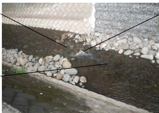
落差があると水中の動植物に必要な酸素が供給できる（落差は生物の移動の妨げにならないようにする。）。
