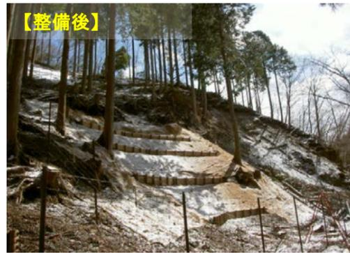
土壌流出防止対策により土壌を安定させて、溪畔人工林の混交林化を図るため、丸太筋工等を実施。
