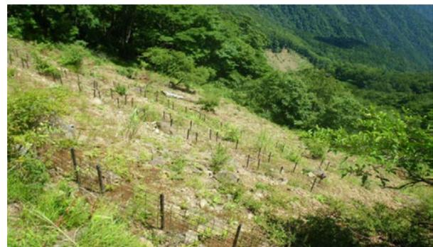
箇所:天王寺尾根ガレ場。金網筋工を面的に配置。植生回復の兆し。今後、落葉を補足し、土壌が形成されれば、更なる植生回復が期待できる。
