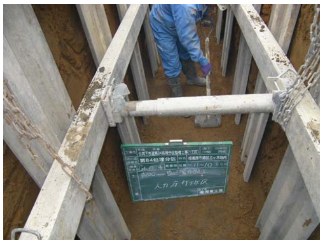
開削工法による下水道管の敷設
