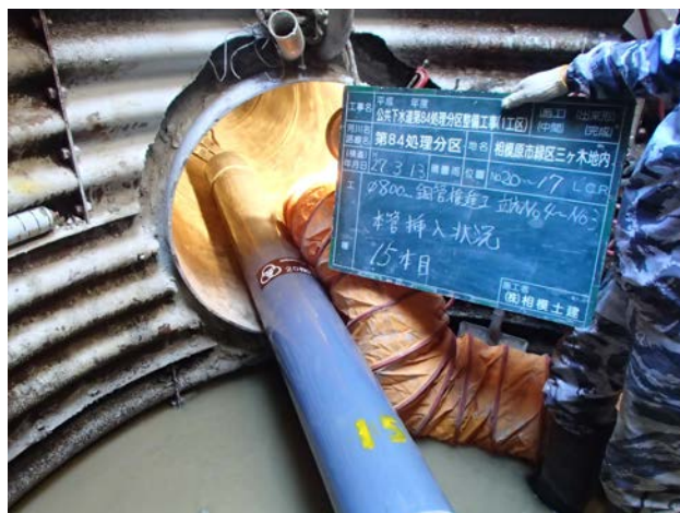
推進工法（道路を開削せず、トンネル状に掘削した穴に管を通す工法）による管の敷設
