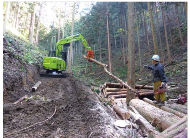
新設した作業道を活用した林業機械による搬出作業
