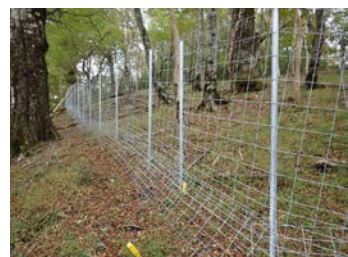
②丹沢大山の保全・再生 シカによる採食を防止し植生を回復させるため、土壤保全対策工事で植生保護柵を設置した。(山北町中川)
