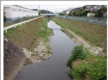
⑥河川・水路における自然浄化対策 川の流れに変化をつけ、水生生物が生息できる環境を創出した。(厚木市恩曾川)
