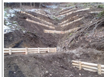
③溪畔林整備 土壌流出が発生している、あるいは発生しそうな箇所土壤保全工を実施した。(山北町仲の沢)
