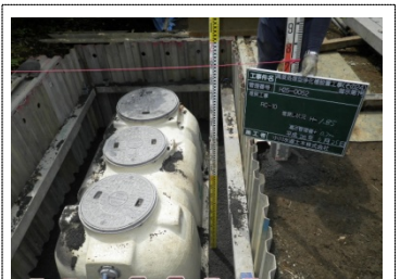
⑧⑨ダム集水域の生活排水対策(下水道・浄化槽) 合併処理浄化槽(5人槽)の整備により、水質改善を図った。(相模原市緑区)
