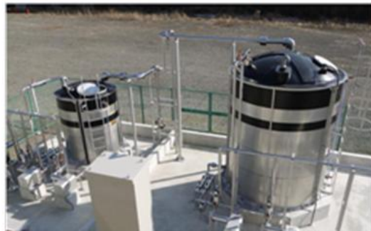
桂川清流センター内に、リン除去設備を設置
