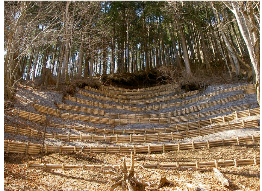
土壌流出防止対策(丸太柵)を実施
