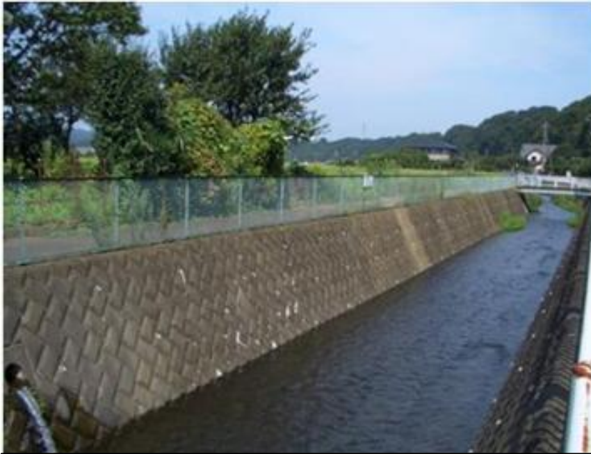
コンクリートブロックにより護岸が整備された河川
