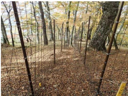
土壌保全対策工事で設置した植生保護柵。シカによる採食を防ぎ、植生を回復させる。
