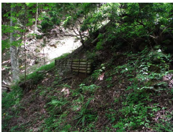
土壌保全工設置箇所（本谷川）
