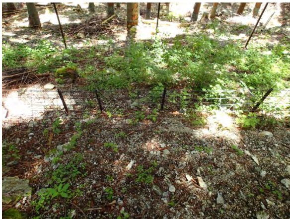
写真 29：土壌保全工(金網柵工)の様子
