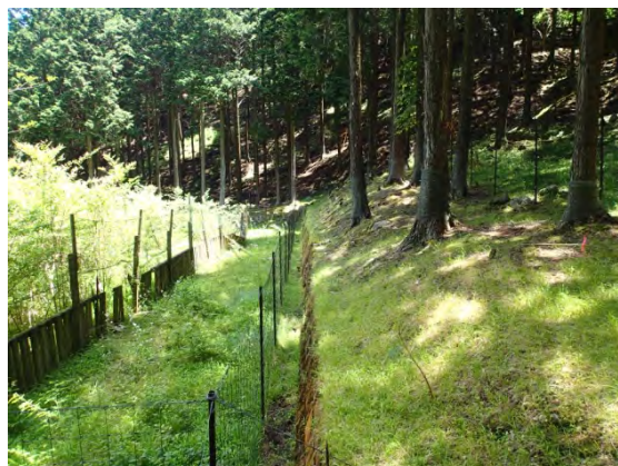
【施工後】（平成 28 年 7 月撮影）
