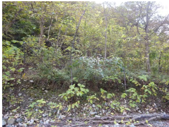
【施工後】（平成26年10月撮影）
