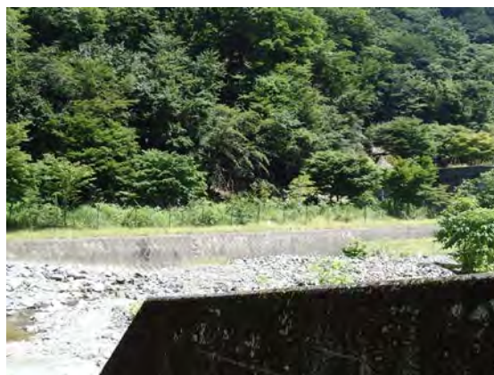
【施工後】（平成26年8月撮影）
