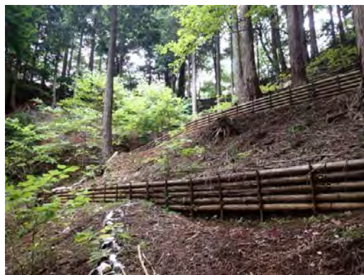
丸太柵工設置箇所（用木沢）
