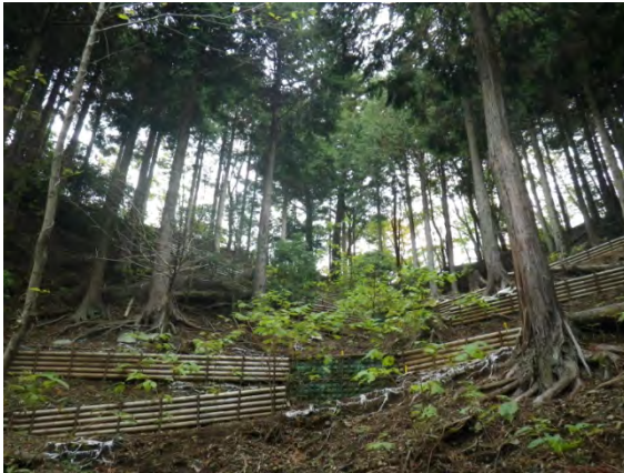
写真 15：丸太柵工・カゴ枠工設置箇所 （用木沢）
