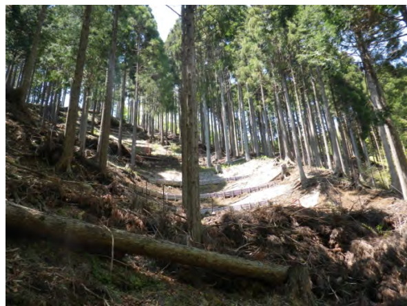
丸太筋工設置箇所（大滝沢）
