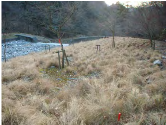
写真 31：整備前の状況（平成 19 年 11 月）
