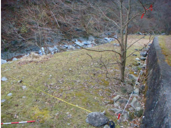
【施工前】（平成 19 年 12 月撮影）
