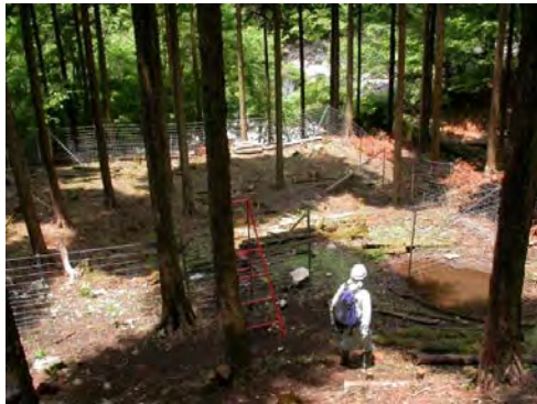
【施工直後】（平成 21 年 6 月）
