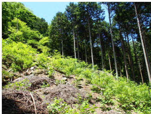
【施工後】（平成 28 年 6 月撮影）
