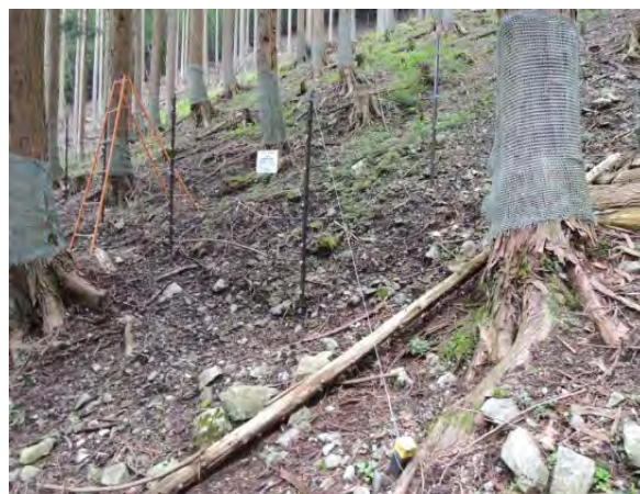
植生保護柵の設置状況（白石沢）
