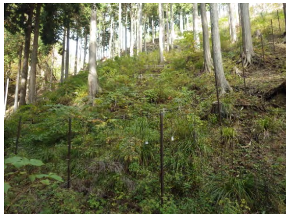
【施工後】（平成 26 年 11 月撮影）
