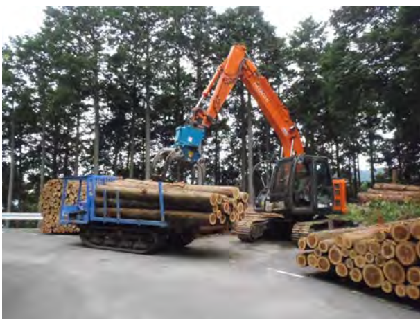
既存の林道を活用した林業機械による搬出作業
