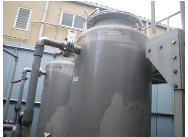
地下水汚染対策（秦野市 浄化施設）
