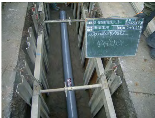
開削工法による下水道管の敷設
