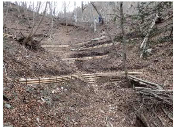
広葉樹整備における土壌保全工実施状況（写真左が丸太筋工、右が丸太積工）
