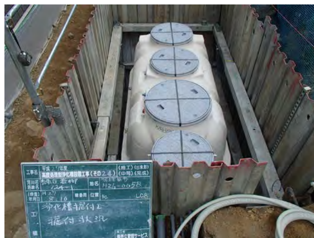
一般家庭への浄化槽設置（5人槽ポンプ付）
