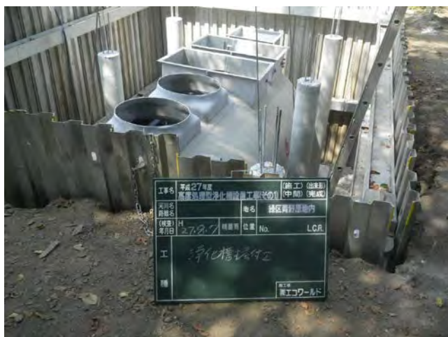
グラウンド管理棟への浄化槽設置(18人槽)
