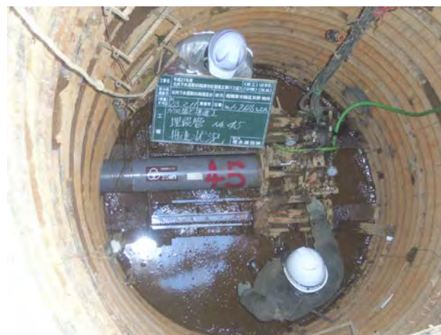
推進工法（道路を開削せず、トンネル状に掘削した穴に管を通す工法）による管の敷設
