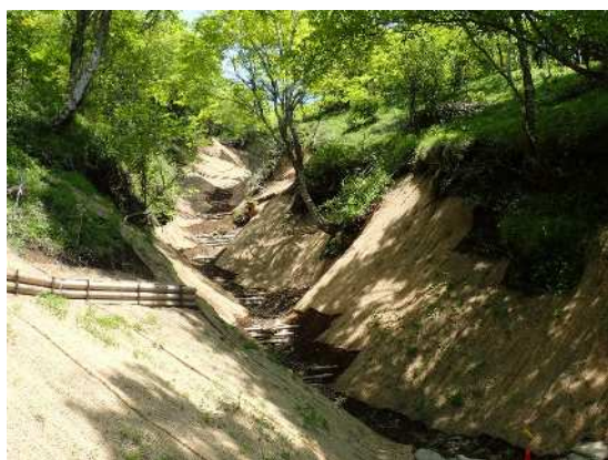
丸太積工とヤシ繊維の植生ネット工による 土壌保全工の状況
