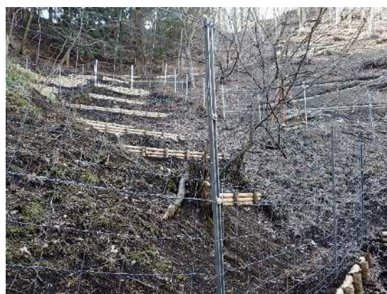
植生保護柵と丸太筋工による土壌保全工の 状況
