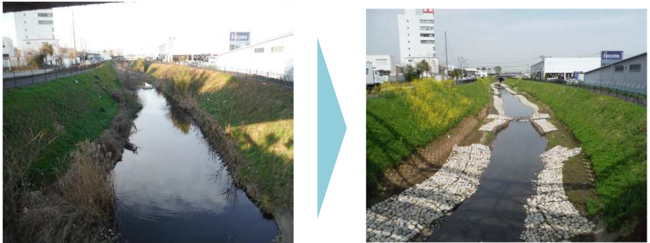
厚木市恩曾川（生態系に配慮した整備）
