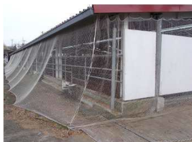
防鳥ネットの補修
