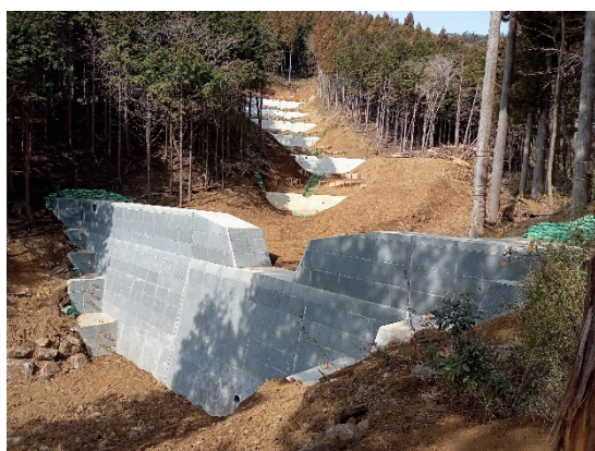
治山施設（谷止工、土留工）
