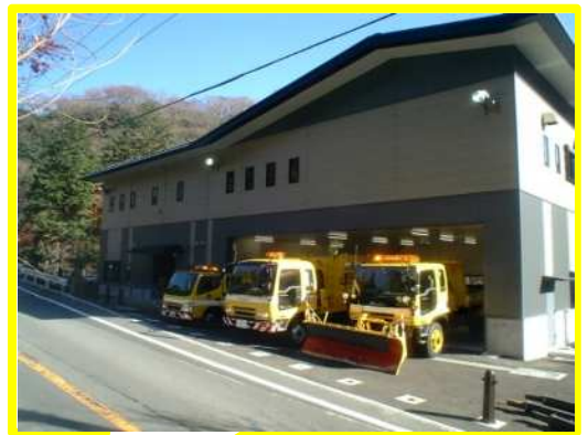
木賀基地 (H16.3 完成)
