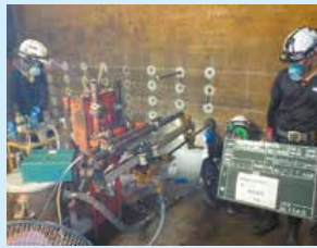
水道施設耐震化事業 (配水池内の工事の様子)
