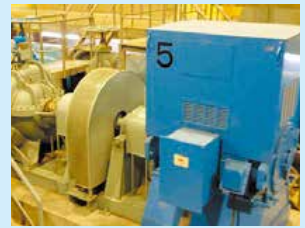
水道施設脱炭素化事業 (省エネルギー効果の高いポンプ設備)
