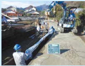
管路更新推進事業 (管路更新工事の様子)
