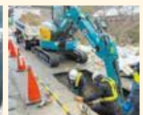
応急復旧工事の様子
