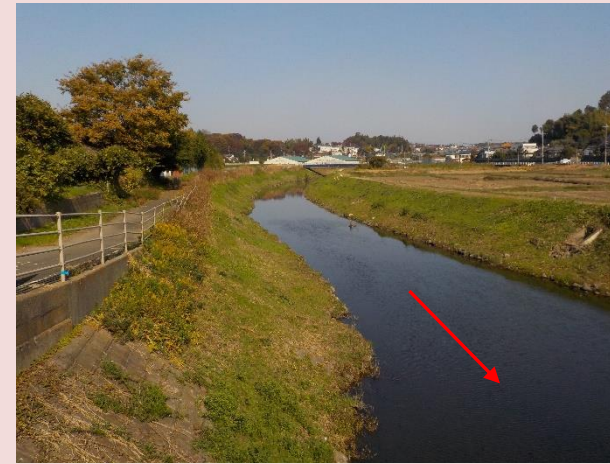
改修前の状況（村野橋上流付近）
