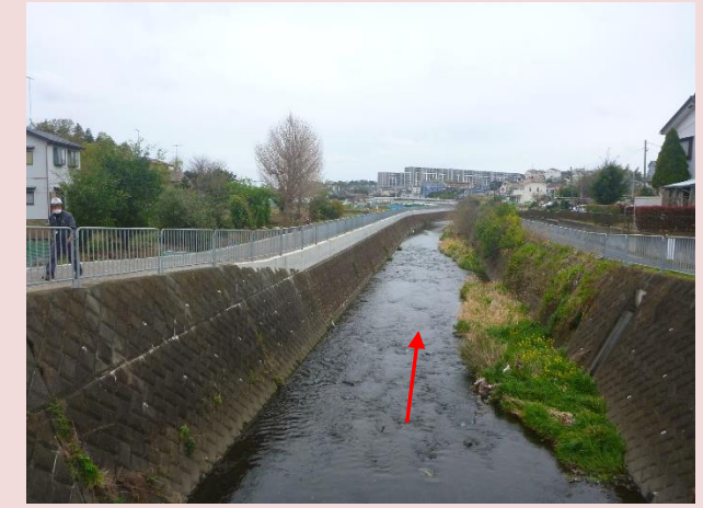
改修後（堤防高上げ）の状況（弥生橋下流付近）
