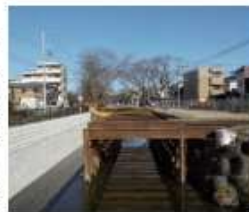
【仮設構台設置状況】
