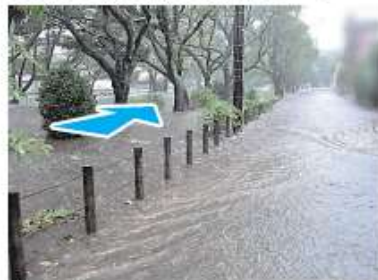
【大雨時の状況(平成26年台風第18号)】
