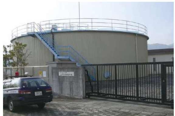
かみおぎの 上荻野東部配水池 (厚木市上荻野)
