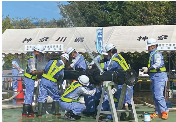
水道管を修理する訓練をしている様子
