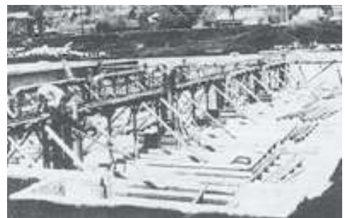
谷ヶ原浄水場の建設工事の様子
