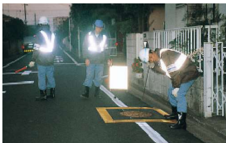
夜間の漏水調査
