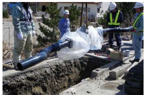
道路をほって水道管を修理している様子
