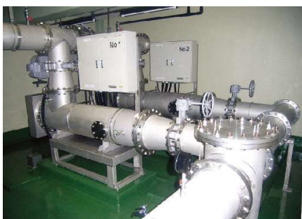
水土野水源の 「紫外線処理設備」
