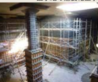
▼配水池の耐震化工事
