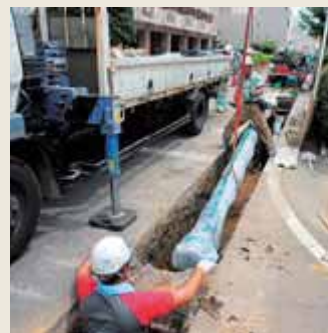
配水管を取り替える際に、耐震継手管を採用しています。
