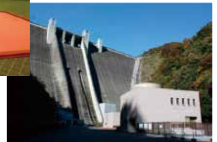
▲愛川第1発電所
